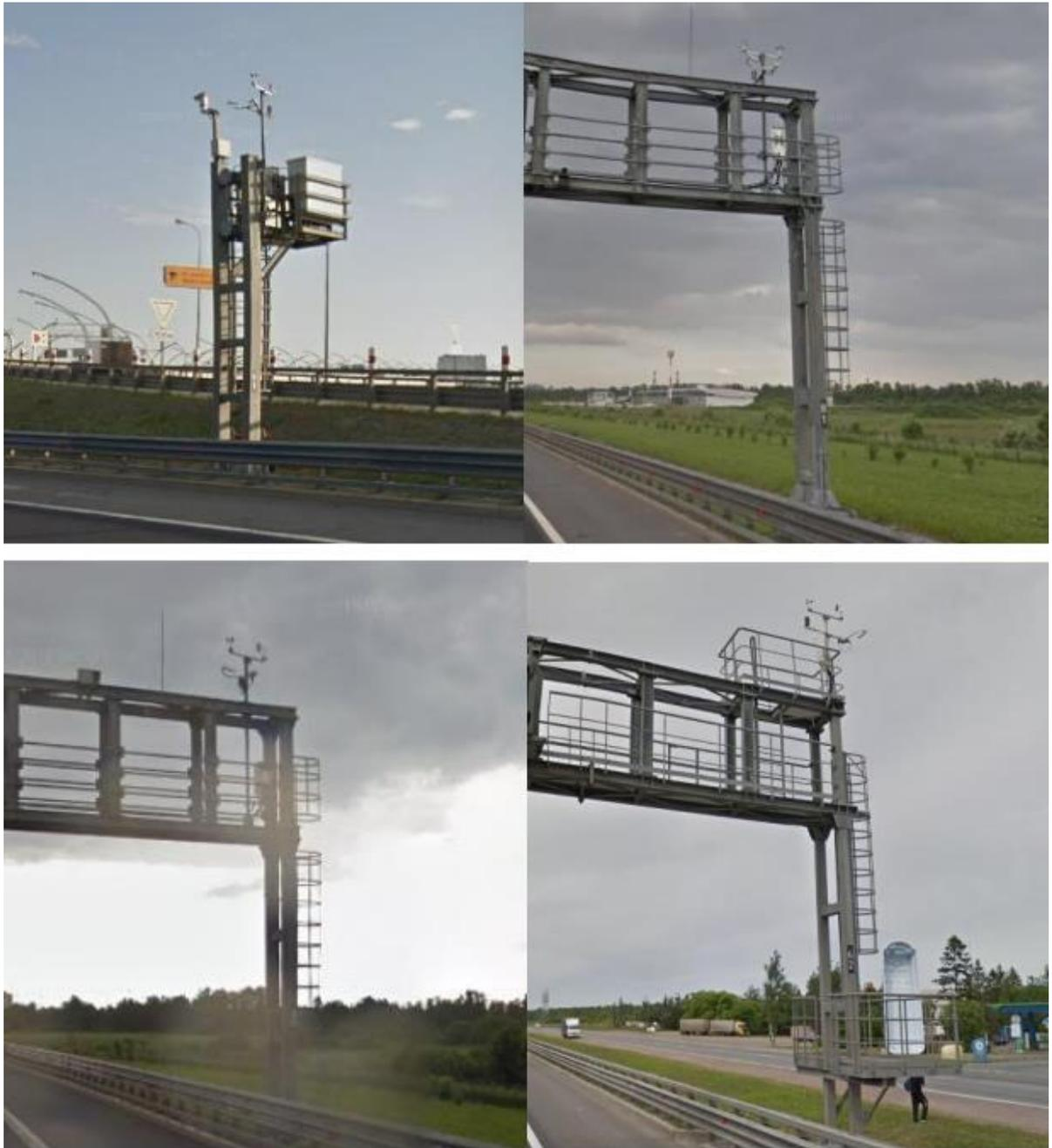
Рисунок 1.18 – Дорожные автоматические метеорологические станции
