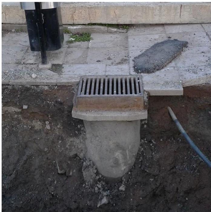
Рисунок 2.6 – Дождевая канализация
