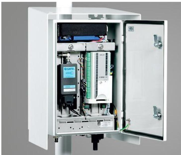
Рисунок 2.3 – Системный блок АДМС
