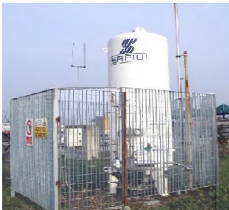
Рисунок 3.5 – Стационарный генератор мелкодисперсных частиц льда на жидком азоте [12, с. 214]
