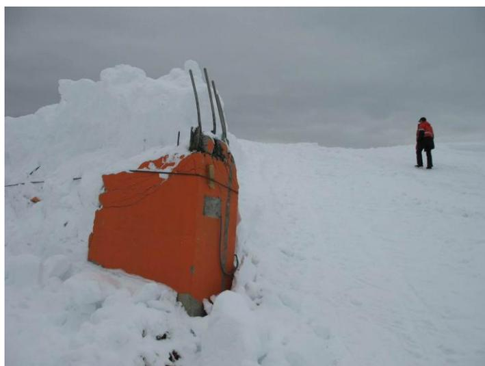
**Рис. 3.14. Окончательное разрушение обводной станции 6-ой очереди ККД (Родниковой) лавиной от 12.02.2006 г.<sup>16</sup>**
