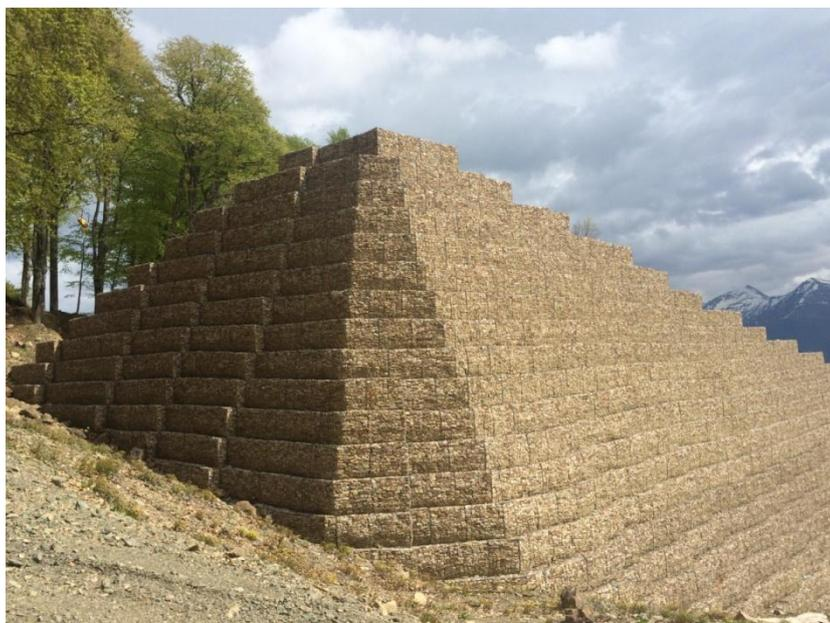
**Рис. 3.3. Снегоотводящая дамба<sup>5</sup>**
