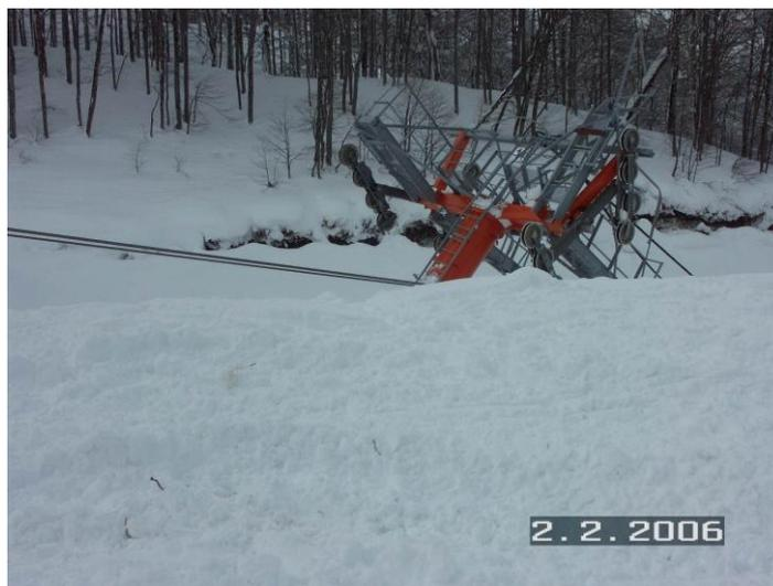
**Рис. 3.13. Последствия лавины 02.02.2006 г. 14-я опора 6-ой очереди ККД (Родниковая)<sup>15</sup>**
