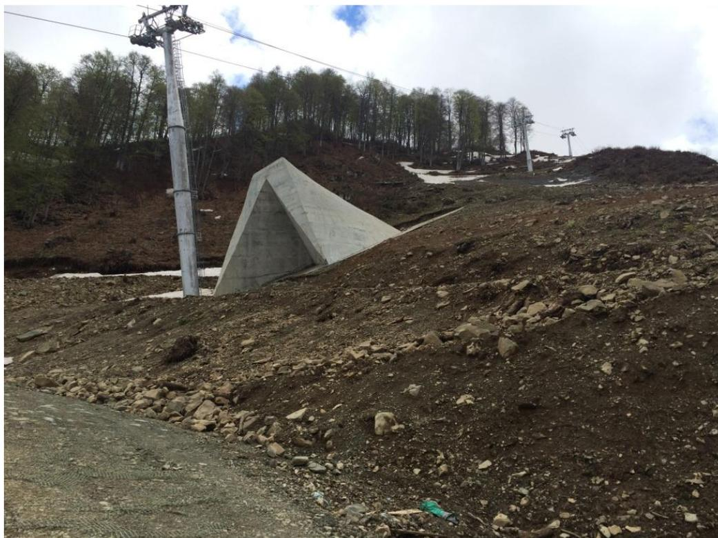
**Рис. 3.2. Лавинорез<sup>4</sup>**
