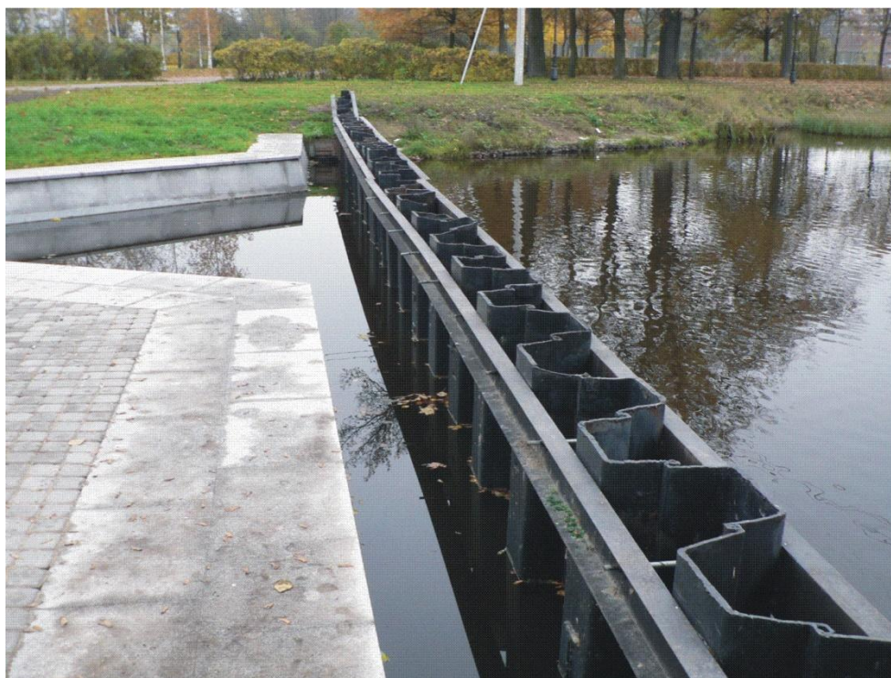
Рис. 4.4. Шпунтовая стенка перед водосбросом в Заводской канал
