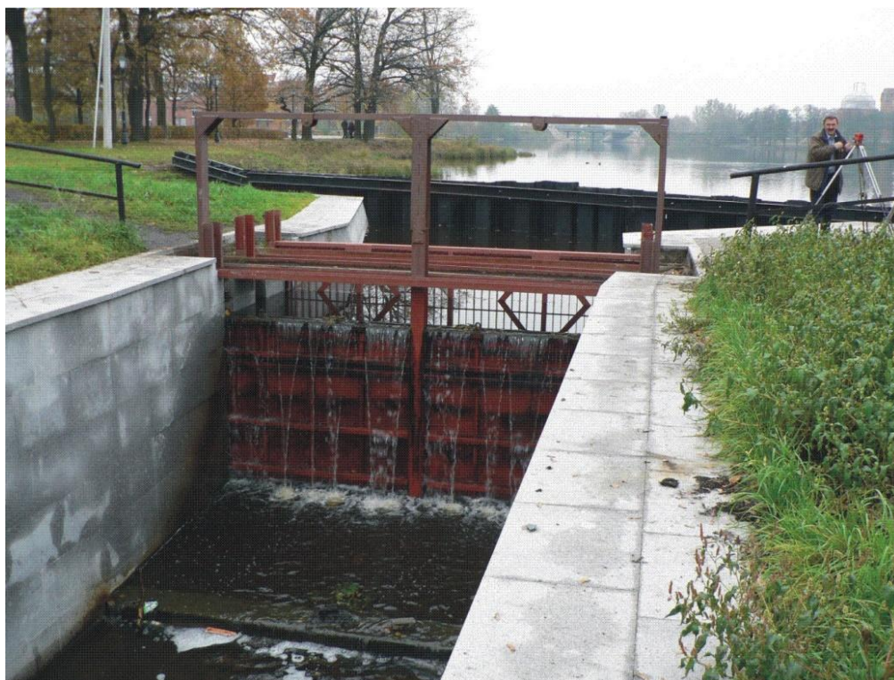
Рис. 4.5. Регулирующие щиты на Заводском канале
