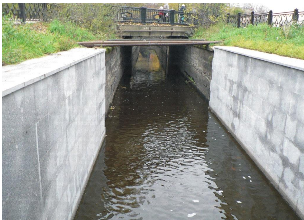
Рис. 4.6. Заводской канал, подводящий воду к турбинам ГЭС на Сестрорецком инструментальном заводе ЗАО «СИЗ Пром»
