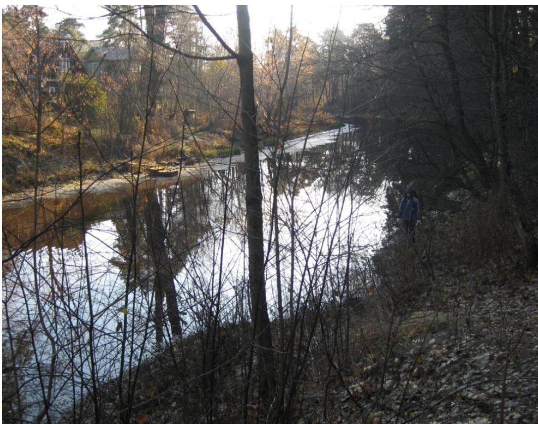
Рис. 4.14. Участок канала ниже по течению от створа перехода -- вид вверх по течению (створ перехода на дальнем плане)
