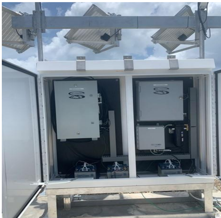
Рисунок 2.8 – Снимок аппаратуры обрабатывающей и передающей метеорологические данные
