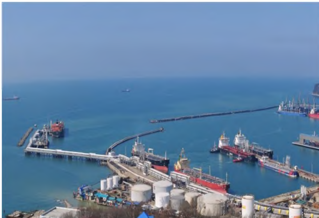
Рисунок 2.2 – Глубоководный нефтеналивной причал в морском порту Туапсе
