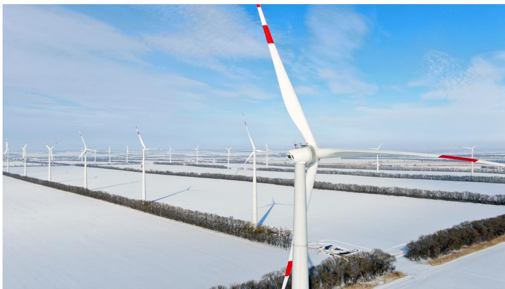
Рисунок 3.1 – ВЭУ 2.5 МВт от НоваВинд на примере Кармалиновской ВЭС [15]
