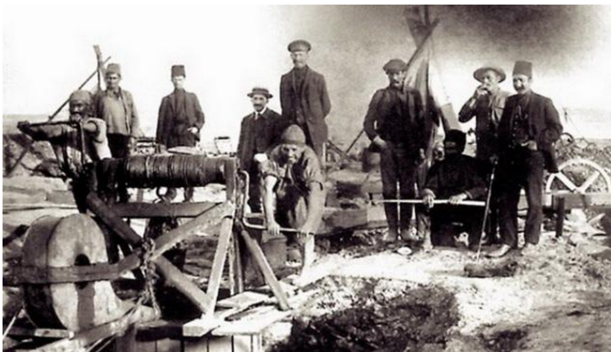
Рисунок 1 - Поднятие нефти ручным воротом в XIX веке на месторождении Биби-Эйбат.
