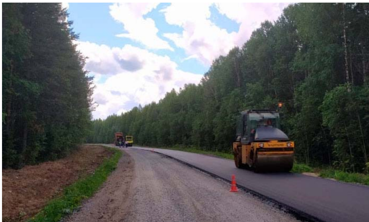
Рисунок 4 - Капитальный ремонт участка автомобильной дороги Верховажье-Нижняя Коленьга 2019.
