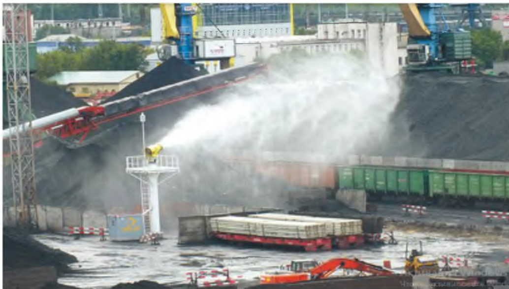
Рисунок 2.4 — Стационарный генератор водяного тумана для подавления пыления при перевалке и складировании угля
