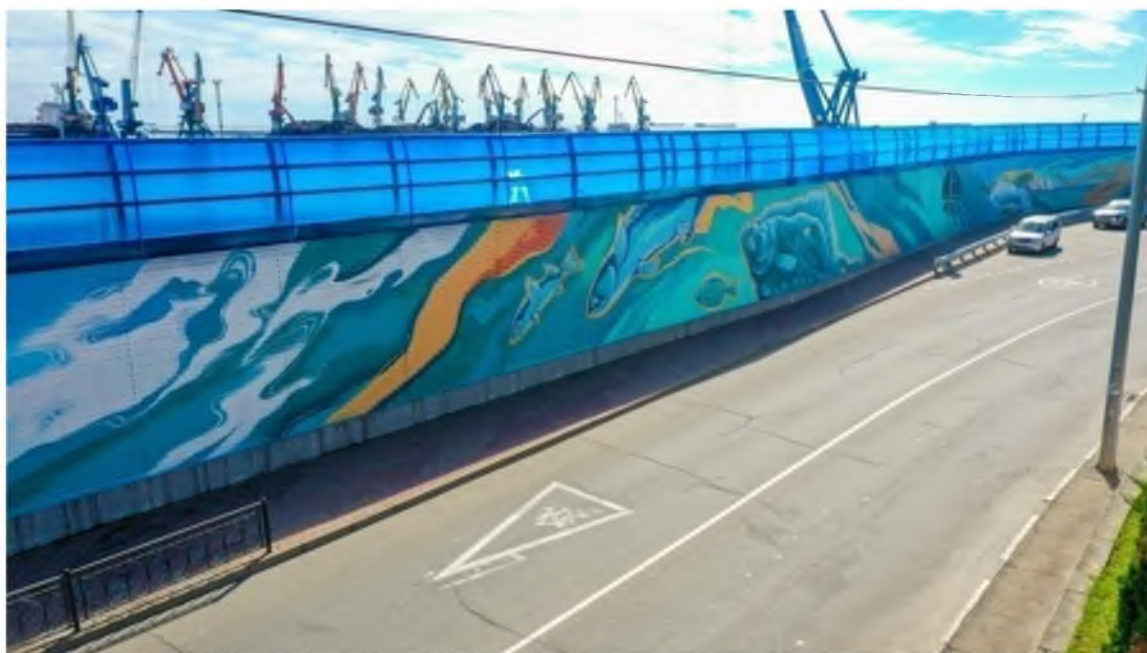
Рисунок 3.2 — Пылешумозащитный экран на границе Туапсинского морского порта
