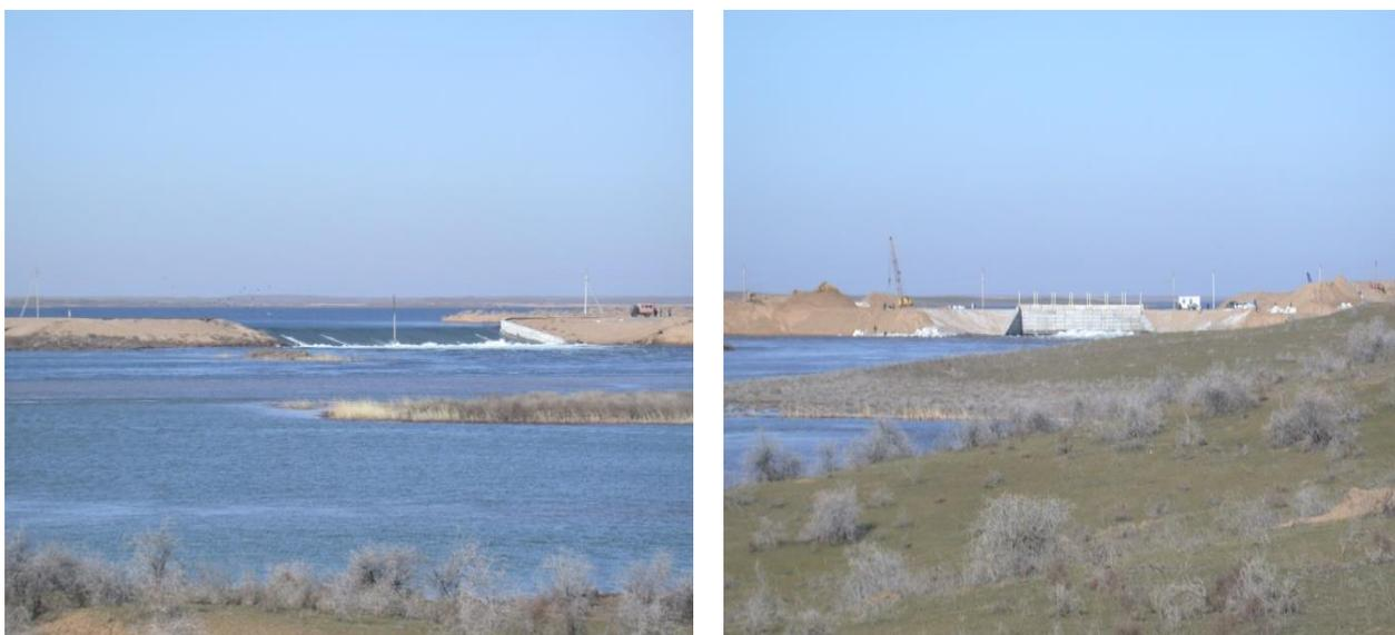
**Рисунок 1.3** – Саморегулируемый и донный водовыпуск плотинного узла №2
