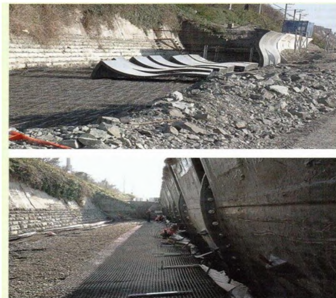
Рисунок 3.4 Стеклопластиковые панели : сверху монтаж панелей ; внизу фланцевые соединения
