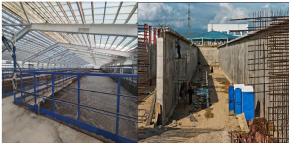
Рисунок 2.7 – Аэротенк в состоянии работы и проектировки
