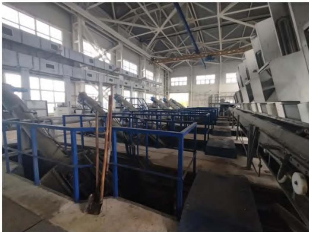
Рисунок 2.4 – Решетки грубой очистки (справа) и решетки тонкой очистки (слева)
