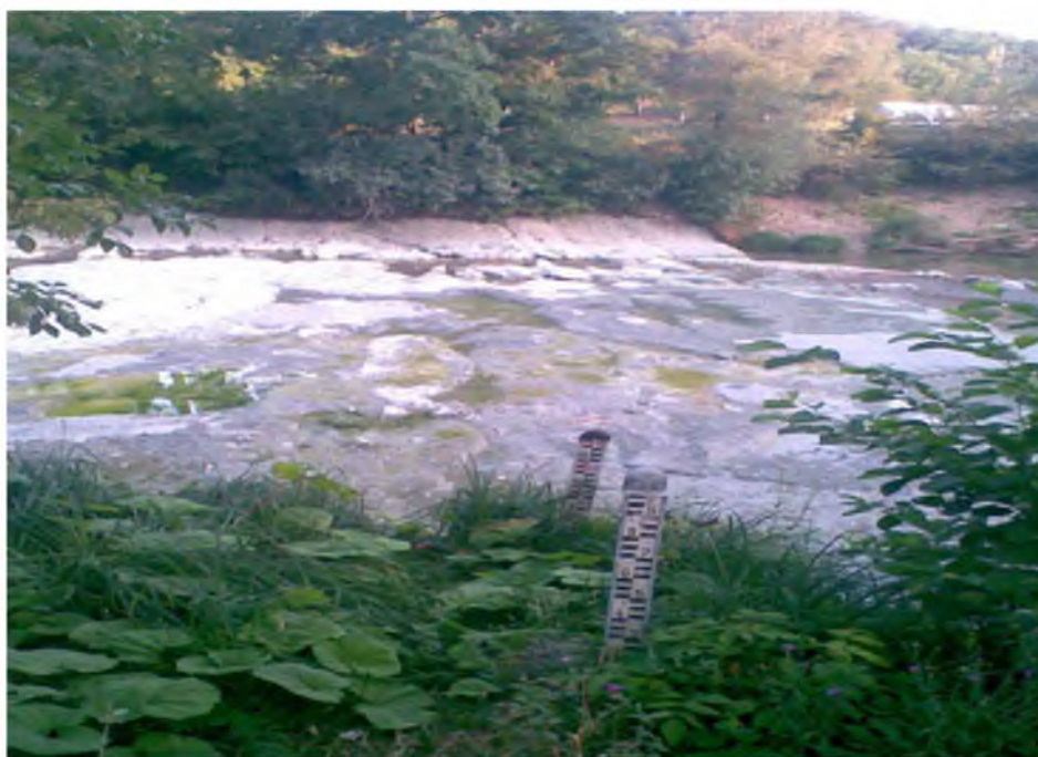
Рисунок 3.6 – Створ водомерного поста р. Псекупс - г. Горячий Ключ с правого берега
